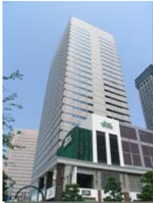
大型オフィスビル 東京/品川区
