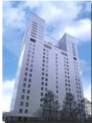
大型複合ビル 東京/品川区
