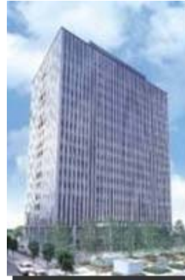
大型オフィスビル 東京/品川区
