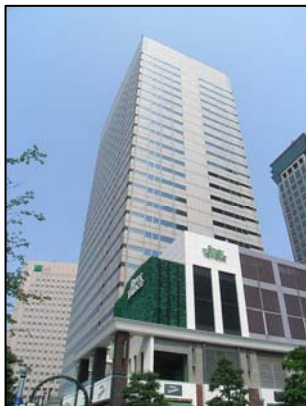
大型オフィスビル 東京/品川区
