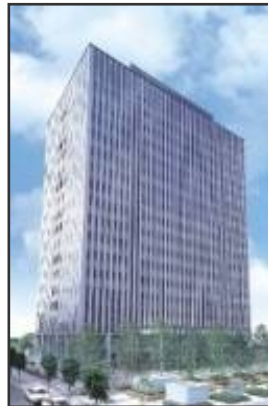
大型オフィスビル 東京/品川区
