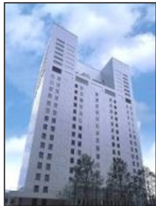
大型複合ビル 東京/品川区
